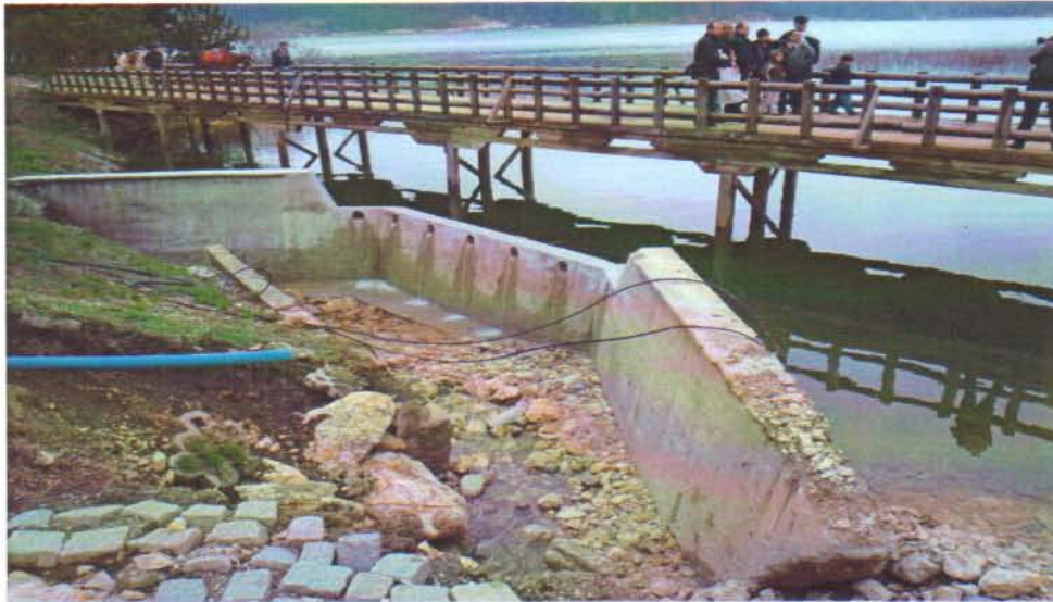
Resim 6: Abant'ın su boşaltımı önüne konulan ve göl seviyesini 2 m yükselten, daha sonra da kaldırılan set (savak). (18.04.2010)
